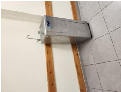
מפגעים קבועים - מצנני מים יהיו מותאמים ויעוגנו לקירות למניעת התהפכות-2-אגף סיעודי-קולר לא מקובע לקיר. סכנת התהפכות- - - - 5-7-23/1/2023 22:09 וניידים
