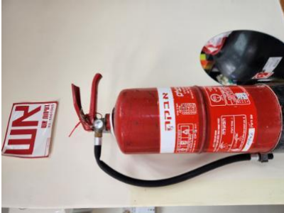
ציוד הכיבוי ומטפי הכיבוי יהיו שלמים, תקינותם ומקומם בהתאם להוראת גילוי וכיבוי אש בהתאם -1-כיתת קשת-מטף כיבוי לא תקין- - - - ציוד ומטפי כיבוי אש-לדרישות מכ"ר 523, יבדקו פעם בשנה לכל הפחות. בכל מוסד חינוכי ימצא מערכות גילוי וכיבוי אש בהתאם לדרישות מכ"ר 523 4-4-23/1/2023 22:18 -מתלי מעילים לא יהיו נמוכים מ-1.80 מטר. במידה והגובה יפחת מ-1.80 מטר יש להתקין מגן-1-כיתת שמש וחדר פרטני-קולבים נמוכים מתנחיות המשרד. ללא הגנה מתאימה- - - - מפגעים - 5-3-23/1/2023 22:21 קבועים וניידים
