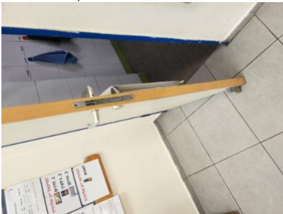
הידיות, המנעולים או חיפויים "(רוזטות)" יהיו -1-כיתת שמש-צילינדר דלת השירותים בתוך החדר לא היה תקין. סכנת הילכדות- - - - 5-24-23/1/2023 22:23 דלתות-שלמים, חלקים וחופשיים מבליטת ברגים, פנים או חלקי פרוזל אחרים
