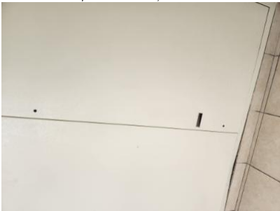
לוחות חשמל לא יהיו עשויים מחומרים דליקים, הארונות יהיו סגורים -1-מול חדר יועצת-ארון חשמל ללא סידורי נעילה מתאימים- - - - 9-1-לוחות חשמל-לארונות וללוחות יהיו סידורי נעילה. לא יהיו חלקים חשופים בלוחות. לא יהיו ארונות חשמל (ראשי/קומתי ואגפלי) בצמוד לכיתות, מעבדות, משרדים וחדרי ספח מאוכלסים 23/1/2023 22:25
