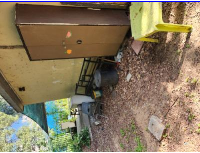
- ארונות, ספריות וכונניות יהיו מקובעים למניעת התהפכות-1חצר דרומית/ מערבית - חצר אחורית-ארון לא מקובע. סכנת התהפכות- - -
