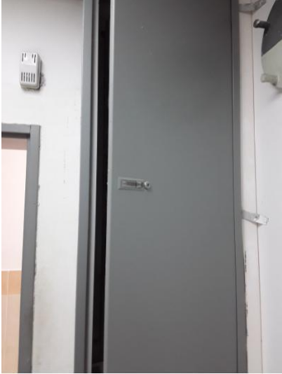
לוחות - כל המעגלים ומפסקי הזרם הראשיים יסומנו בסימון בר-קיימא-2-חדר 107 מבנה שכבת כתות י-ארון חשמל ללא שילוט- - -
