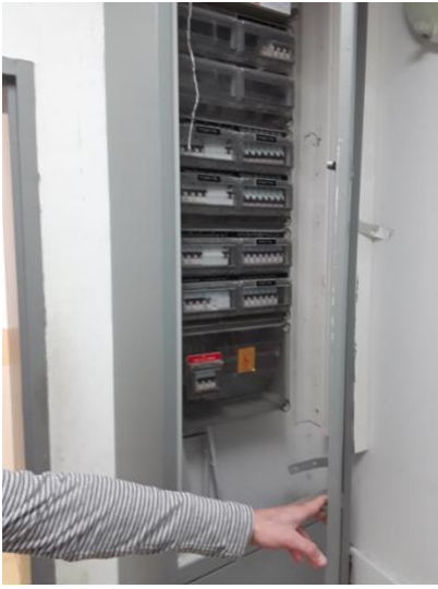
לוחות - כל המעגלים ומפסקי הזרם הראשיים יסומנו בסימון בר-קיימא-2-חדר 107 מבנה שכבת כתות י-ארון חשמל ללא שילוט- - -
