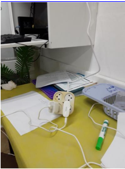
-9.5-מפסקים ושקעים- כל אביזרי החשמל יהיו שלמים ומקובעים למקומם-1-כתה י 9-שמוש במפצל חשמל-אילתור חשמל- - -
