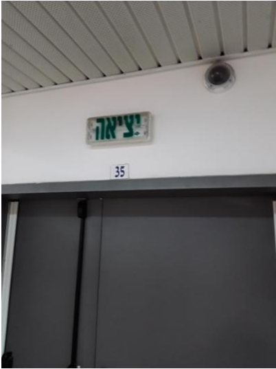
-מפסקים ושקעים-. כל אביזרי החשמל יהיו שלמים ומקובעים למקומם-2-מבנה ז פרוזדור-שלט יציאה תאורה בשלט לא תקינה- - - 9.5-26/2/2023 12:11
