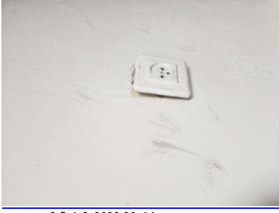
מפסקים - כל אביזרי החשמל יהיו שלמים ומקובעים למקומם-0-חדר 414-שקע חשמלי לא מקובע למקומו. חוטי חשמל גלויים- - - 9.5-4/2/2023 20: 16-ושקעים
