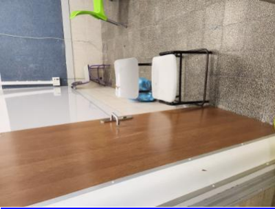
שער כניסה במבנה 600 / הדלתות בכיתות מוסד החינוך - אין תפס שתופס את הדלת בסוף תנועת פתיחתה בהתאם להנחיות לעיל- - - הדלתות תצוידנה באבזר או באבזורים לצורך המטרות הבאות: א. מגן אצבעות בשני צידי הצירים באזורים שבהם יש אפשרות להילכדות אצבעות. ב. האטת אגף-1 ובחזרי הספח - מפגע גורף אצבעות ואלמנט קיבוע שיותאם לדלת. ה. הדלת במהלך סגירתו. ג. מעצור דלת במצב פתוח. האבזר יותקן בקיר, בגובה אגף הדלת ולא ברצפה. ד. במקלט ובמרחב מוגן יש להתקין מגן 5.23-4/2/2023 19: 50-דלתות- בדלתות קלות של שירותים נדרשת הגנה מתאימה
