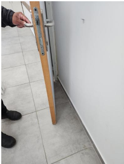
חדלתות תצוידנה באבזר או באבזרים לצורך המטרות הבאות: א. מגן אצבעות 1-כיתת קרוואן א-1-חסר גלגלון האטה חסר סטופר לדלת- - - בשני צידי הצירים באזורים שבהם יש אפשרות להילכדות אצבעות. ב. האטת אגף הדלת במהלך סגירתו. ג. מעצור דלת במצב פתוח. האבזר יותקן בקיר, בגובה אגף הדלת ולא ברצפה. ד. במקלט חדרות וכווניות יהיו מקובעים 1-חדר 108-ארון לא מקובע לקיר. ארון מועמד לפינוי לא מקובע לקיר. סכנת התחככות ופציעה- - - 5-23-26/1/2023 7: 38 דלתות-ובמרחב מוגן יש להתקין מגן אצבעות ואלמנט קיבוע שיותאם לדלת. ה. בדלתות קלות של שירותים נדרשת הגנה מתאימה
