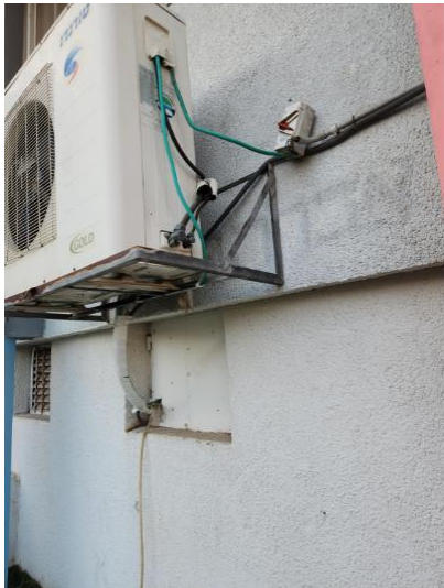
כבלי חשמל קבועים יושמו 1-חצר אחורית-כבל חשמלי מזין את המזגן לא מחובר לקיר בצורה תקינה. כבל חשמלי מחובר לנשא המזגן- - - 9-26/1/2023 7: 33 חיווט וכבלי חשמל-בתוך תעלות מתאימות כבלי חשמל לא יהיו בהישג ידם של הילדים/תלמידים
