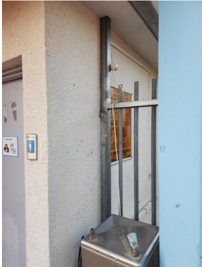
כבלי חשמל קבועים יושמו בתוך תעלות מתאימות כבלי חשמל לא 1-חצר בית הספר-כבל חשמלי מזין את הקולר מחובר לגדק מתכתית- - - 9-26/1/2023 7: 30 חיווט וכבלי חשמל-יהיו בהישג ידם של הילדים/תלמידים
