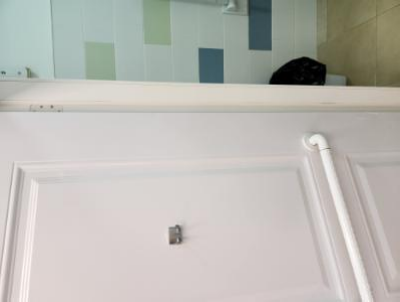
חדר אומנות/ חדר פרטני/ -אין מגיני אצבעות בצידה הפנימי של הדלת. אין מגן אצבעות בצידה החיצוני של הדלת. מגן אצבעות לא תקין- - - הדלתות תצוידנה באזור או באזורים לצורך המטרות הבאות : א. מגן אצבעות בשני צידי הצירים באזורים שבהם יש אפשרות להילכדות אצבעות. 1-חדרים 17 ו 18/ שירותי בנות/ חדר יופר ועוד ב. האטת אגף הדלת במהלך סגירתו. ג. מעצור דלת במצב פתוח. האזור יותקן בקיר, בגובה אגף הדלת ולא ברצפה. ד. במקלט ובמרחב מוגן יש להתקין מגן אצבעות ואלמנט קיבוע שיותאם לדלת. 5.23-6/2/2023 22: 59-דלתות-ה. בדלתות קלות של שירותים נדרשת הגנה מתאימה
