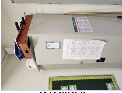
מפגעים - ארונות, ספריות וכוונניות יהיו מקובעים למניעת התהפכות-1-כיתה א/2 / בית מדרש- ארון לא מקובע לקיר. סכנת תהפכות- - -
