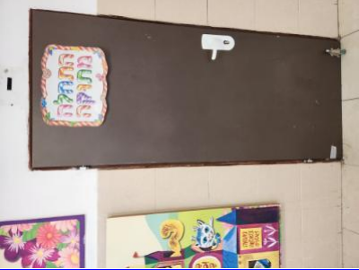
הדלתות תצוידנה -1-דלת כניסה ראשית/ דלתות כיתות לימוד/ מפגע גורף-לא הותקן תפס שיכול לתפוס את כנף הדלת בסוף תנועתה- - - באזור או באזורים לצורך המטרות הבאות : א. מגן אצבעות בשני צידי הצירים באזורים שבהם יש אפשרות להילכדות אצבעות. ב. האטת אגף הדלת במהלך סגירתו. ג. מעצור דלת במצב פתוח. דלתות-האזור יותקן בקיר, בגובה אגף הדלת ולא ברצפה. ד. במקלט ובמרחב מוגן יש להתקין מגן אצבעות ואלמנט קיבוע שיותאם לדלת. ה. בדלתות קלות של שירותים נדרשת הגנה מתאימה 5.23-6/2/2023 22: 51
