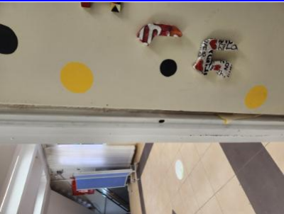
חדר אומנות/ חדר פרטני/ -אין מגיני אצבעות בצידה הפנימי של הדלת. אין מגן אצבעות בצידה החיצוני של הדלת. מגן אצבעות לא תקין- - - הדלתות תצוידנה באזור או באזורים לצורך המטרות הבאות : א. מגן אצבעות בשני צידי הצירים באזורים שבהם יש אפשרות להילכדות אצבעות. 1-חדרים 17 ו 18/ שירותי בנות/ חדר יופר ועוד ב. האטת אגף הדלת במהלך סגירתו. ג. מעצור דלת במצב פתוח. האזור יותקן בקיר, בגובה אגף הדלת ולא ברצפה. ד. במקלט ובמרחב מוגן יש להתקין מגן אצבעות ואלמנט קיבוע שיותאם לדלת. 5.23-6/2/2023 22: 59-דלתות-ה. בדלתות קלות של שירותים נדרשת הגנה מתאימה
