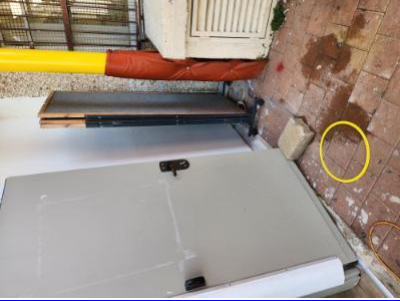
הדלתות תצוידנה -1-דלת כניסה ראשית/ דלתות כיתות לימוד/ מפגע גורף-לא הותקן תפס שיכול לתפוס את כנף הדלת בסוף תנועתה- - - באזור או באזורים לצורך המטרות הבאות : א. מגן אצבעות בשני צידי הצירים באזורים שבהם יש אפשרות להילכדות אצבעות. ב. האטת אגף הדלת במהלך סגירתו. ג. מעצור דלת במצב פתוח. דלתות-האזור יותקן בקיר, בגובה אגף הדלת ולא ברצפה. ד. במקלט ובמרחב מוגן יש להתקין מגן אצבעות ואלמנט קיבוע שיותאם לדלת. ה. בדלתות קלות של שירותים נדרשת הגנה מתאימה 5.23-6/2/2023 22: 51
