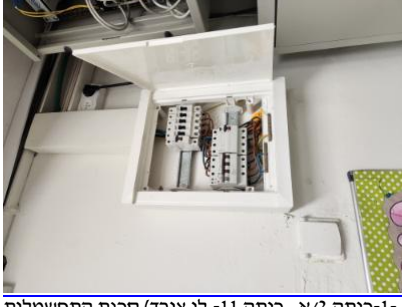
לוח חשמל גבוה בכיתה א/2 נמצא ללא מכסה. חוטים חשופים בלוח החשמל. שקע חשמל תעשייתי/ תלת פאזי נמצא בתוך הכיתה (אין) - - -
