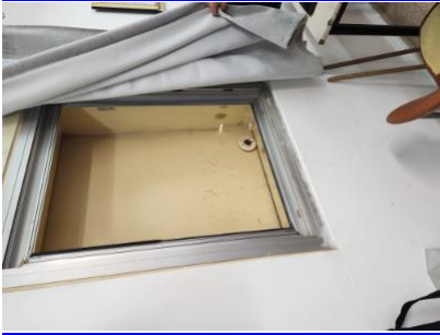
פתחי החירום של המקלט היוצאים אל -2-חדר מורים- בנים-חלונות הממ"ד לא שלמים. חסר זכוכית בחלונות הממ"ד- - - - 6.9-16/2/2023 19: 16-פתחי חירום- שטח החצר יהיו סגורים מבפנים, ולא יבלטו מעל פני השטח
