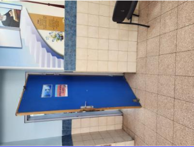
הדלתות תצוידנה -1-כיתות לימוד, חדרי ספח וחדרי מנהלה.-לא נמצאו סטופרים / תפסים העונים להנחיות משרד החינוך- - - באבזר או באבזרים לצורך המטרות הבאות: א. מגן אצבעות בשני צידי הצירים באזורים שבהם יש אפשרות להילכדות אצבעות. ב. האטת אגף הדלת במהלך סגירתו. ג. מעצור דלת במצב פתוח. האבזר יותקן בקיר, בגובה אגף הדלת ולא ברצפה. ד. במקלט ובמרחב מוגן יש להתקין מגן אצבעות ואלמנט קיבוע שיותאם לדלת. ה. בדלתות קלות של שירותים
