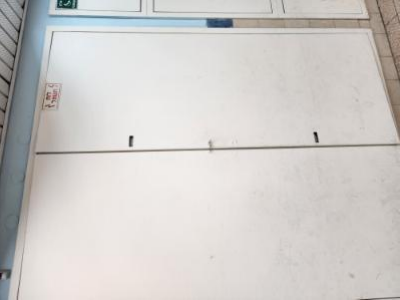
לוחות -1-מסדקונות מוסד החינוך.-הדלתות של ארונות החשמל/ לוחות החשמל נמצאו ללא סידורי נעילה מתאימים- - - חשמל לא יהיו עשויים מחומרים דליקים, הארונות יהיו סגורים לארונות וללוחות יהיו סידורי נעילה. לא יהיו חלקים חשופים בלוחות. לא יהיו ארונות חשמל (ראשי/קומתי ואגפי)
