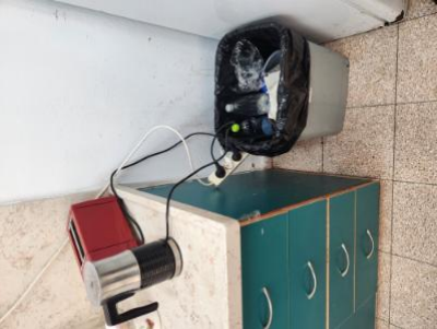
מפסקים - כל אביזרי החשמל יהיו שלמים ומקובעים למקומם-1-חדר מורות- אגף הבנות.-מפצל חשמל מזין את המקרר- - -
