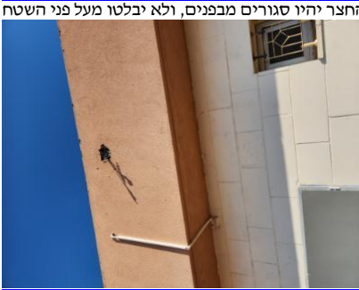
גופי התאורה בחדרי השירותים ובחצר יהיו -2-קיר חיצוני בחצר חיצונית דרומית- חוטים גלויים של גוף תאורה בחצר- - - - 9.7-16/2/2023 19: 20-מנורות וגופי תאורה- מטיפוס מוגן-מים
