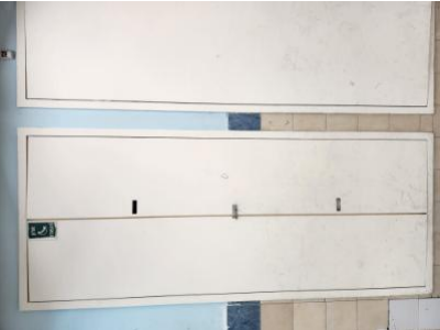
לוחות -1-מסדקונות מוסד החינוך.-הדלתות של ארונות החשמל/ לוחות החשמל נמצאו ללא סידורי נעילה מתאימים- - - חשמל לא יהיו עשויים מחומרים דליקים, הארונות יהיו סגורים לארונות וללוחות יהיו סידורי נעילה. לא יהיו חלקים חשופים בלוחות. לא יהיו ארונות חשמל (ראשי/קומתי ואגפי)
