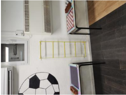
סולמות המקלט ללא הגנה למניעת טיפוס. 2. המדרגה בכניסה למקלט ללא סימון מתאים ולא מונעת נחלקה. 3. דלת המקלט לא 1. - - - בכל מקום בו קיימת סתירה בין הוראות פיקוד העורף -1-. המקלט בבית הספר-נפתחת עד סוף תנועת הפתיחה. דלת המקלט נתקעת ברצפה. סכנת פציעה. מוכנות לא מספקת לשעת חירום -שגרה (לא בחירום)-. והוראות הבטיחות, בזמן שגרה יגברו הוראות הבטיחות תוך כדי מתן אפשרות מהירה לעבור למצב חירום. כקיבוע או סורגים על חלונות מילוט, ומניעת טיפוס על סולמות 6.1-20/2/2023 19:11
