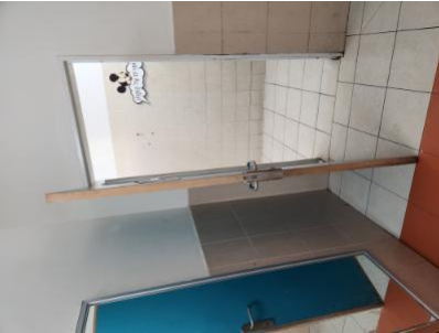
הדלתות תצוידנה באבזר או באבזרים לצורך -1-'אגפי השירותים בקומה א-לא הותקן מנגנון האטה מתאים על הדלתות. סכנת פציעה- - - המטרות הבאות: א. מגן אצבעות בשני צידי הצירים באזורים שבהם יש אפשרות להילכדות אצבעות. ב. האטת אגף הדלת במהלך סגירתו. ג. מעצור דלת במצב פתוח. האבזר יותקן בקיר, בגובה 5.23-20/2/2023 19: 00 דלתות-אגף הדלת ולא ברצפה. ד. במקלט ובמרחב מוגן יש להתקין מגן אצבעות ואלמנט קיבוע שיותאם לדלת. ה. בדלתות קלות של שירותים נדרשת הגנה מתאימה
