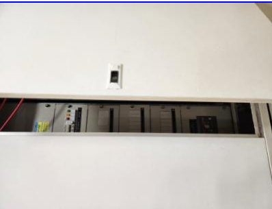
לוחות חשמל לא יהיו עשויים -1-מסדרונות מוסד החינוך-לוחות החשמל נמצאו ללא סידורי נעילה מתאימים. סכנת התחשמלות- - - מחומרים דליקים, הארונות יהיו סגורים לארונות וללוחות יהיו סידורי נעילה. לא יהיו חלקים חשופים בלוחות. לא יהיו ארונות חשמל (ראשי/קומתי ואגפי) בצמוד לכיתות, מעבדות, משרדים 9.1-20/2/2023 18: 58 לוחות חשמל-וחדרי ספח מאוכלסים
