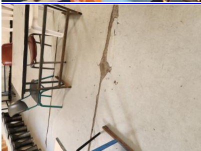
מבנה -הרצפה בחדר המוסיקה לא שלמה/ תקינה . סכנת נפילה ופציעה. 2. המרזב מעל הקרוואן לא נמצא יציב/ תקין. סכנת פציעה. 1. - - - מפגעים קבועים וניידים- לא יהיו מפגעי תשתית בבניין ובכיתות ובפרט סדקים במבנה, רצפות שקועות, סימני רפיון (כגון "בטן") בתקרות תלויות ומפגעי תשתית אחרים-1-יביל/ חדר מוסיקה 5.10-20/2/2023 19:18
