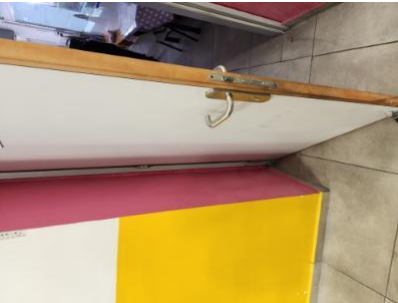
הדלתות תצוידנה באבזר או באבזרים -1-כיתות לימוד. מפגע גורף-לא נמצא תפס מתאים בדלתות מוסד החינוך. סכנת פציעה באצבעות- - - לצורך המטרות הבאות: א. מגן אצבעות בשני צידי הצירים באזורים שבהם יש אפשרות להילכדות אצבעות. ב. האטת אגף הדלת במהלך סגירתו. ג. מעצור דלת במצב פתוח. האבזר יותקן בקיר, 5.23-20/2/2023 18: 56 דלתות-בגובה אגף הדלת ולא ברצפה. ד. במקלט ובמרחב מוגן יש להתקין מגן אצבעות ואלמנט קיבוע שיותאם לדלת. ה. בדלתות קלות של שירותים נדרשת הגנה מתאימה
