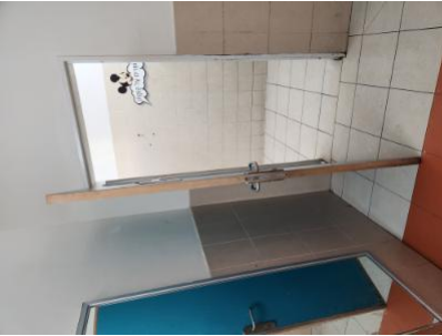
הדלתות תצוידנה באבזר או באבזרים -1-כיתות לימוד. מפגע גורף-לא נמצא תפס מתאים בדלתות מוסד החינוך. סכנת פציעה באצבעות- - - לצורך המטרות הבאות: א. מגן אצבעות בשני צידי הצירים באזורים שבהם יש אפשרות להילכדות אצבעות. ב. האטת אגף הדלת במהלך סגירתו. ג. מעצור דלת במצב פתוח. האבזר יותקן בקיר, 5.23-20/2/2023 18: 56 דלתות-בגובה אגף הדלת ולא ברצפה. ד. במקלט ובמרחב מוגן יש להתקין מגן אצבעות ואלמנט קיבוע שיותאם לדלת. ה. בדלתות קלות של שירותים נדרשת הגנה מתאימה
