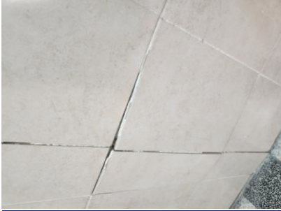
לא יהיו מפגעי תשתית בבניין ובכיתות -1-קומה שלישית-אריחי קרמיקה מתפרקים. סדק בין החיבור של שני המבנים. סכנת פציעה- - - מפגעים קבועים וניידים-ובפרט סדקים במבנה, רצפות שקועות, סימני רפיון (כגון "בטון") בתקרות תלויות ומפגעי תשתית אחרים 5.10-4/3/2023 23:07
