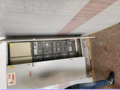
לוחות חשמל לא יהיו עשויים 1-מקלט, אולם ספורט. מפגע גורף.-לוחות החשמל ללא סידורי נעילה מתאימים. סכנת התחשמלות- - - מחומרים דליקים, הארונות יהיו סגורים לארונות וללוחות יהיו סידורי נעילה. לא יהיו חלקים חשופים בלוחות. לא יהיו ארונות חשמל (ראשי/קומתי ואגף) בצמוד לכיתות, מעבדות, משרדים 9.1-4/3/2023 22: 57-לוחות חשמל-וחדרי ספח מאוכלסים
