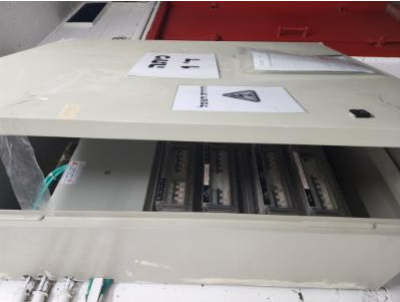
לוחות חשמל לא יהיו עשויים 1-מקלט, אולם ספורט. מפגע גורף.-לוחות החשמל ללא סידורי נעילה מתאימים. סכנת התחשמלות- - - מחומרים דליקים, הארונות יהיו סגורים לארונות וללוחות יהיו סידורי נעילה. לא יהיו חלקים חשופים בלוחות. לא יהיו ארונות חשמל (ראשי/קומתי ואגף) בצמוד לכיתות, מעבדות, משרדים 9.1-4/3/2023 22: 57-לוחות חשמל-וחדרי ספח מאוכלסים
