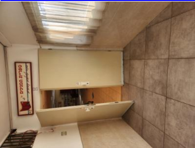
לא קיים תפס מתאים בדלת הספריה. לא קיים תפס מתאים בדלתות אולם הספורט. לא קיים מגן אצבעות תקין בדלת אולם - - - הידיות, המנעולים או חיפויים "(רוזטות)" יהיו שלמים, חלקים וחופשיים מבליטת ברגים, פנים או 1-ספריה, אולם ספורט. כיתות לימוד-הספורט. לא קיים תפס מתאים בדלתות מוסד החינוך 5.24-4/3/2023 23: 02-דלתות-חלקי פרזול אחרים
