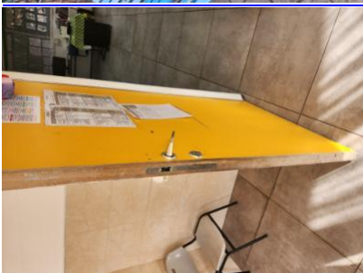
הידיות, המנעולים או חיפויים "(רוזטות)" יהיו שלמים, חלקים וחופשיים מבליטת -1-כיתה 22-צילינדר לא תקין בדלת. סכנת פציעה- - - ברגים, פינים או חלקי פרוול אחרים 5.24-4/3/2023 23:13
