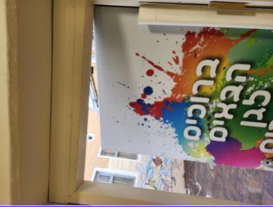
הדלתות תצוידנה -1-דלת יציאה לחצר מקראית-לא נמצא מנגנון האטה מתאים או סטופר ייעודי לתפוס את כנף הדלת בסוף תנועתה- - - - באבזר או באבזרים לצורך המטרות הבאות: א. מגן אצבעות בשני צידי הצירים באזורים שבהם יש אפשרות להילכדות אצבעות. ב. האטת אגף הדלת במהלך סגירתו. ג. מעצור דלת במצב פתוח. -דלתות-. האבזר יותקן בקיר, בגובה אגף הדלת ולא ברצפה. ד. במקלט ובמרחב מוגן יש להתקין מגן אצבעות ואלמנט קיבוע שיותאם לדלת. ה. בדלתות קלות של שירותים נדרשת הגנה מתאימה 5.23-4/2/2023 13: 37
