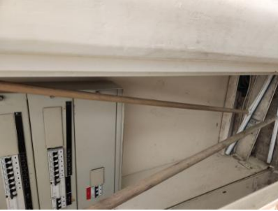
לוחות חשמל -1-ליד כיתה 1/ג וגם ליד כיתה 1/ה-.לוחות חשמל ללא סידורי נעילה מתאימים. איחסון ציוד ניקיון בארונות החשמל- - - - לא יהיו עשויים מחומרים דליקים, הארונות יהיו סגורים לארונות וללוחות יהיו סידורי נעילה. לא יהיו חלקים חשופים בלוחות. לא יהיו ארונות חשמל (ראשי/קומתי ואגפי) בצמוד לכיתות, 9.1-4/2/2023 13: 44-לוחות חשמל-מעבדות, משרדים וחדרי ספח מאוכלסים
