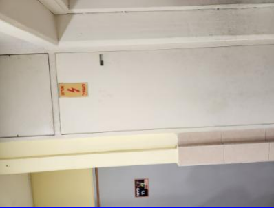
לוחות חשמל -1-ליד כיתה 1/ג וגם ליד כיתה 1/ה-.לוחות חשמל ללא סידורי נעילה מתאימים. איחסון ציוד ניקיון בארונות החשמל- - - - לא יהיו עשויים מחומרים דליקים, הארונות יהיו סגורים לארונות וללוחות יהיו סידורי נעילה. לא יהיו חלקים חשופים בלוחות. לא יהיו ארונות חשמל (ראשי/קומתי ואגפי) בצמוד לכיתות, 9.1-4/2/2023 13: 44-לוחות חשמל-מעבדות, משרדים וחדרי ספח מאוכלסים
