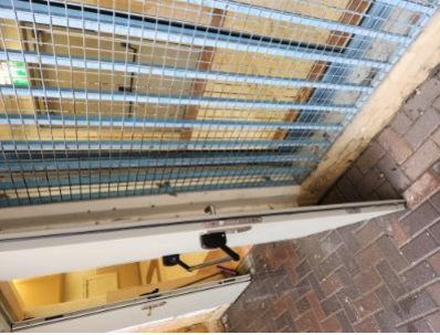
הדלתות -1-דלת יציאה לחצר הגולה. חדר 18. מפגע גורף-לא נמצא סטופר בדלת. אין תפס מתאים לתפוס את כנף הדלת בסוף תנועתה- - - - תצוידנה באבזר או באבזרים לצורך המטרות הבאות: א. מגן אצבעות בשני צידי הצירים באזורים שבהם יש אפשרות להילכדות אצבעות. ב. האטת אגף הדלת במהלך סגירתו. ג. מעצור דלת במצב פתוח. האבזר יותקן בקיר, בגובה אגף הדלת ולא ברצפה. ד. במקלט ובמרחב מוגן יש להתקין מגן אצבעות ואלמנט קיבוע שיותאם לדלת. ה. בדלתות קלות של שירותים נדרשת הגנה 5.23-4/2/2023 15: 15-דלתות-. מתאימה
