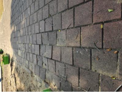
1-השביל מכיוון ביקתת השומר אל בית הספר-מהמורות בשביל, והפרשי גבהים בין האבנים המשתלבות בשביל. סכנת נפילה ופציעה- - - 3.1-23/1/2023 22: 49-תשתיות-. החצר תהיה נקייה ממפגעי בטיחות קבועים או זמניים, ללא בליטות או שקעים, ולא יישארו בה מכשולים או פסולת מכל סוג . חלקים בולטים יהיו עם הגנה עליהם
