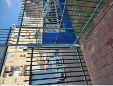
מבנה המעקה יקשה אפשרות 1-מעקה צמוד לשער ולביקתת השומר-מעקה מאפשר טיפוס צמוד לשער הכניסה. סכנת נפילה ופציעה- - - -טיפוס (כרכיבים אופקיים, בליטות, חריצים או כל חלק המאפשר טיפוס). סורגי המעקה יהיו אנכיים, והמרווח ביניהם לא יותר מ- 10 ס"מ, או פתרון אחר התואם את דרישות חוזר מנכ"ל 3.20-23/1/2023 22: 42-מפלסים בחצר
