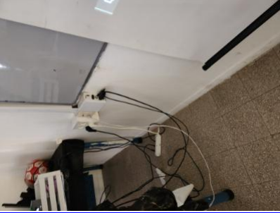
כבלי חשמל קבועים יושמו בתוך תעלות 1-2) חדר מחשבים, כיתת שני-.שימוש במפצלים וכבלים על הרצפה. סכנת התחשמלות- - -
