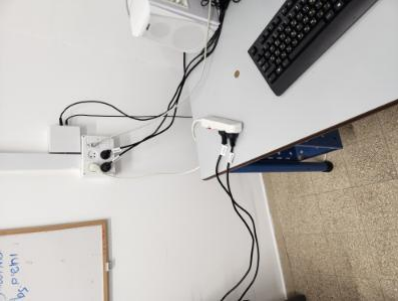
כבלי חשמל קבועים יושמו בתוך תעלות 1-2) חדר מחשבים, כיתת שני-.שימוש במפצלים וכבלים על הרצפה. סכנת התחשמלות- - -
