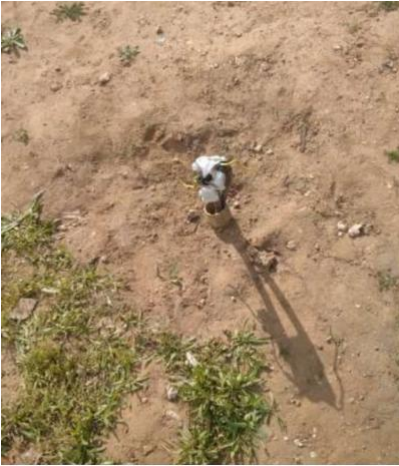
גופי תאורה יהיו מוגנים -1-מאחורי דלת היציאה של החצר האחורית-גוף תאורה שבור. מכסה הגוף עשוי מזכוכית. סכנת פציעה- - - 9.8-20/1/2023 19: 25-מנורות וגופי תאורה.-מפגיעה פיזית
