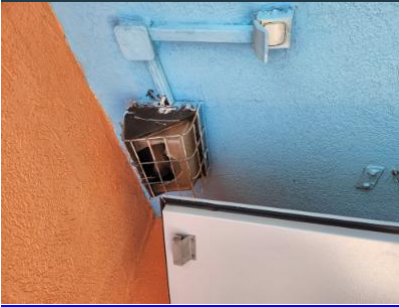
גופי תאורה יהיו מוגנים -1-מאחורי דלת היציאה של החצר האחורית-גוף תאורה שבור. מכסה הגוף עשוי מזכוכית. סכנת פציעה- - - 9.8-20/1/2023 19: 25-מנורות וגופי תאורה.-מפגיעה פיזית
